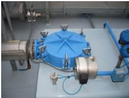
Figuur 3: Ontgassingspunt (klep gesloten)
