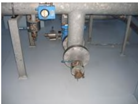
Figuur 5: Opening 2" word tijdens droog blazen van leidingwerk geopend
